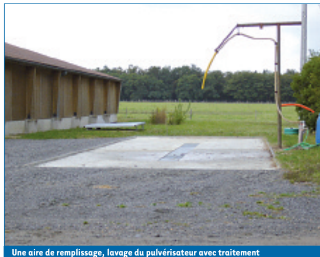
Une aire de remplissage, lavage du pulvérisateur avec traitement
